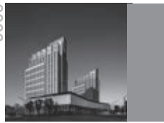
苏州月亮湾福朋酒店和喜月阁 Four Points Hotel and Moon Bay Mansion, Suzhou 所在地: 苏州 用地面积: 19,000 平方米 总建筑面积: 75,500 平方米 竣工时间: 2011 年
