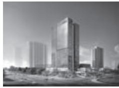
南通融创·希尔顿酒店 Sunac Hilton Hotel, Nantong 所在地: 南通 用地面积: 29,200 平方米 总建筑面积: 105,800 平方米
