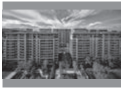
杭州万科·星空 Vanke Dreams Starry, Hangzhou 所在地: 杭州 用地面积: 700 平方米 总建筑面积: 500 平方米 竣工时间: 2018 年
