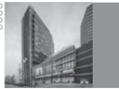
苏州狮山日航酒店 Suzhou Shishan Nikko Hotel 所在地: 苏州 用地面积: 19,000 平方米 总建筑面积: 143,800 平方米 竣工时间: 2015 年
