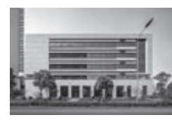
中国船级社浙江分社 China Classification Society Zhejiang Branch Office 所在地: 宁波 用地面积: 60,000 平方米 总建筑面积: 19,300 平方米 竣工时间: 2015 年
