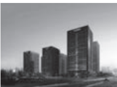
武汉光谷金融港三期 Optics Valley Financial Harbour Phase III, Wuhan, PRC 所在地: 武汉 用地面积: 88,000 平方米 总建筑面积: 349,750 平方米
