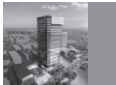
苏州柯利达研发楼 Kelida Research and Development Building, Suzhou 所在地: 苏州 用地面积: 12,000 平方米 总建筑面积: 59,100 平方米 竣工时间: 2018 年
