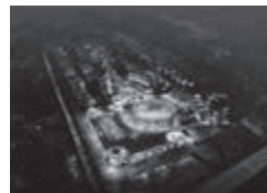
唐泉广场 Tangquan Square 所在地: 天津 用地面积: 159,000 平方米 总建筑面积: 222,800 平方米
