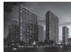
青岛胶州万科·公园大道 Vanke Park Avenue, Qingdao 所在地: 青岛 用地面积: 52,973 平方米 总建筑面积: 153,622 平方米
