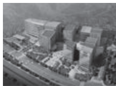
南都电源新能源创新产业园 NARADA New Energy Innovation Industrial Park, Hangzhou 所在地: 杭州 用地面积: 18,000 平方米 总建筑面积: 39,500 平方米
