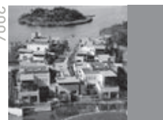
天津梅江南水岸公馆 MJN Waterfront Community, Tianjin 所在地：天津 用地面积：200,000 平方米 总建筑面积：230,000 平方米 竣工时间：2009 年
