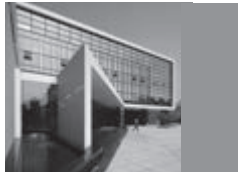
苏州柯利达办公楼改造 Kelida Office Building Renovation, Suzhou 所在地: 苏州 竣工时间: 2003 年
