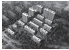
杭州绿都·未来科技城南湖住宅项目 Lvdu Future Sci-Tech City Nanhu District Residential, Hangzhou 所在地: 杭州 用地面积: 37,731 平方米 总建筑面积: 109,299 平方米
