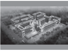
上海高润·吉宝新场 Jibao Xinchang, Shanghai 所在地: 上海 用地面积: 24,643 平方米 总建筑面积: 26,235 平方米
