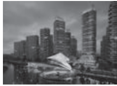
嘉兴万科·未来社区 Vanke Future Community, Jiaxing 所在地: 嘉兴 用地面积: 275,000 平方米 总建筑面积: 851,657 平方米
