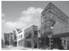
苏州金鸡湖水巷邻里 Waterfront Commercial, Suzhou 所在地: 苏州 用地面积: 120,000 平方米 总建筑面积: 100,000 平方米 竣工时间: 2007 年
