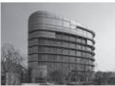
江阴贝卡尔特亚洲研发中心 Bekaert Asia R&D Center, Jiangyin 所在地: 江阴 用地面积: 18,000 平方米 总建筑面积: 20,400 平方米 竣工时间: 2009 年
