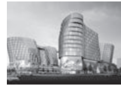
长九实业综合发展项目 Changjiu Commercial Complex Project, Hangzhou 所在地: 杭州 用地面积: 96,000 平方米 总建筑面积: 23,5400 平方米
