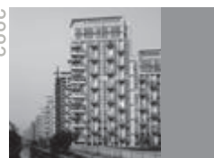
名馨南苑一主语城 Mingxin Zhuyu Garden, Suzhou 所在地：苏州 用地面积：83,000 平方米 总建筑面积：127,000 平方米 竣工时间：2008 年
