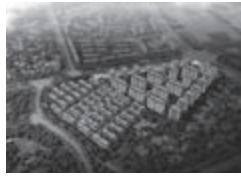
福建融创·晋江印 Sunac In Jinjiang, Fujian 所在地: 福建 用地面积: 113,827 平方米 总建筑面积: 235,320 平方米
