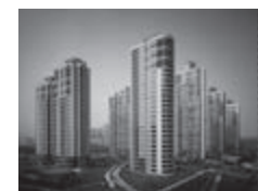
天津时代奥城 Olympic City, Tianjin 所在地：天津 用地面积：250,000 平方米 总建筑面积：537,000 平方米 竣工时间：2006 年
