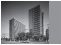
上海尚尚杰座 JMS Office, Shanghai 所在地: 上海 用地面积: 10,000 平方米 总建筑面积: 33,000 平方米 竣工时间: 2006 年
