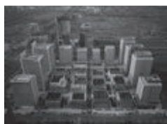
合肥光谷联合·金融港二期 Hefei Financial Harbour Phase II 所在地：合肥 用地面积：144,435 平方米 总建筑面积：652,953 平方米 竣工时间：2019 年
