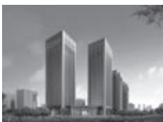
鼎龙产业园 Dinglong Headquarter Industry Park, wuhan 所在地: 武汉 用地面积: 178,000 平方米 规划建筑面积: 434,300 平方米
