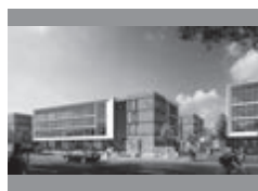
延安创新科技产业园 Innovation Science and Technology Industrial Park, Yan'an 所在地：延安 用地面积：130,114 平方米 总建筑面积：155,126 平方米
