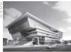
宁波职工之家 Ningbo Eastern New Town 's Labour Union project 所在地: 宁波 用地面积: 75,000 平方米 总建筑面积: 103,100 平方米
