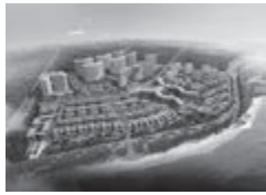
海口首开·美墅湾 Beijing Capital Changliu Mix-used Project, Haikou 所在地: 海口 用地面积: 241,000 平方米 总建筑面积: 374,230 平方米
